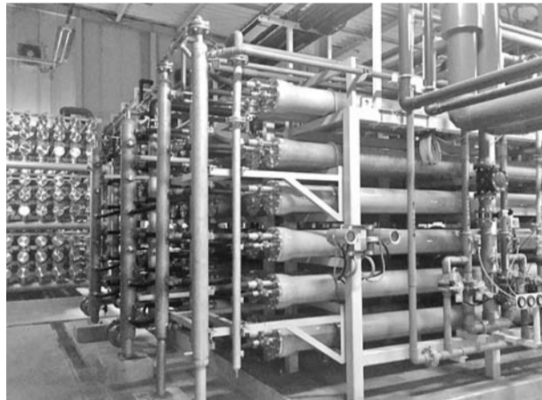
半導体工場の水リサイクル施設(ラピスセミコンダクタ宮城の膜処理システム。ローム提供)
