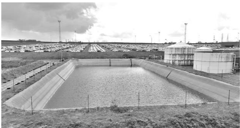
工業用水利用量の約45%削減に成功したフランス工場の雨水貯留施設
