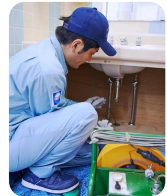
管清工業の秘密兵器、高速回転するフレキシロッターで管内の汚れを落とす。
