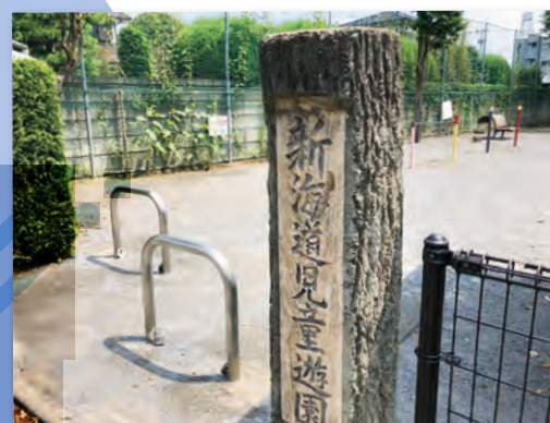
雨水浸透施設の上部は、公園として活用されています。
