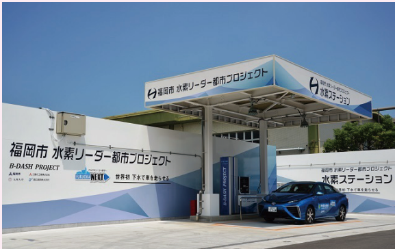
下水汚泥から水素を作り、 燃料電池自動車（FCV）へ供給する水素ステーション（福岡市）
