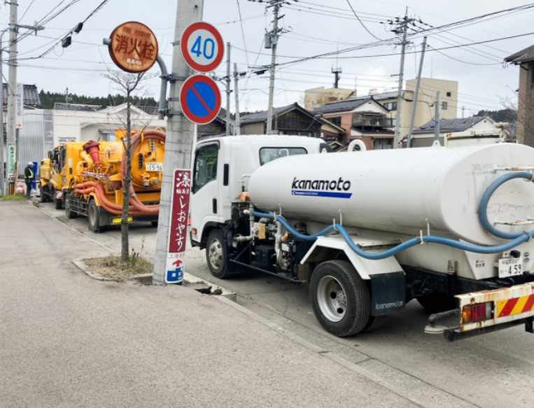
下水道管調査の様子。吸引、洗浄、テレビカメラでの撮影など、多くの設備が必要になる。写真提供：管清工業
