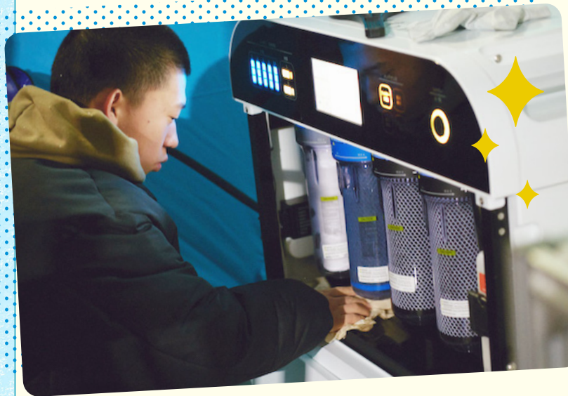
WOTAのシステムは操作やメンテナンスが簡単だからこそ、レクチャーを受ければ運用が可能になる。珠洲市の避難所では、中学生が「WOTA BOX」のメンテナンスをしていた。写真提供：WOTA株式会社
